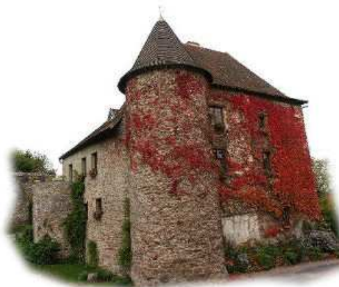
Maison des Dîmes - 03120 Châtelus
